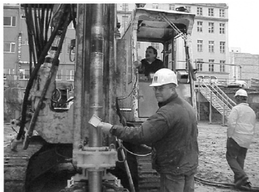
Figuur 4/6: Overdracht van de opgemeten helling van de groutlans (Doc. Bauer GmbH).
