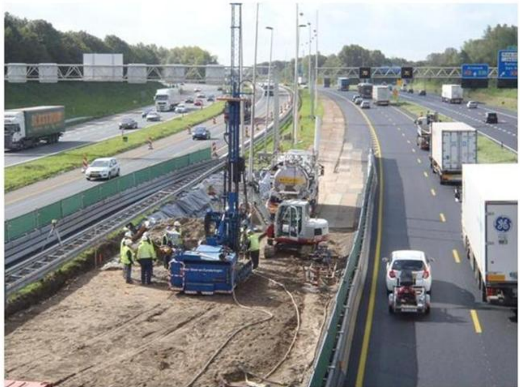
Figuur 12/11: Impressie uitvoeringswerkzaamheden ter plaatse van de pijler in de tussenberm van A27.
