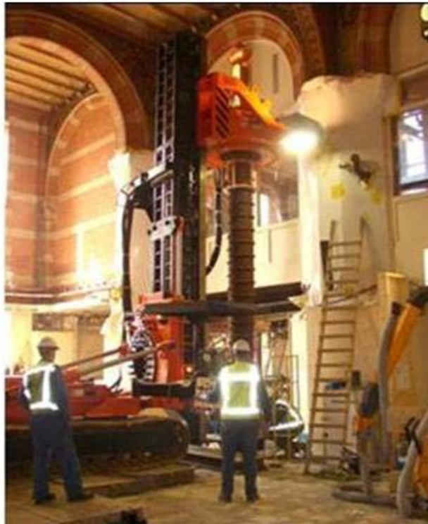
Figuur 11/5: Inbrengen van Tubexpalen met de Topdrill.
