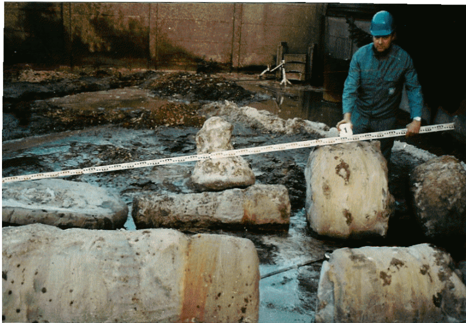
Figuur 7/2: Proefpaal uitgevoerd te Dessel met mono-jet waarbij de retourstroming geblokkeerd werd (Rapport KU Leuven).
