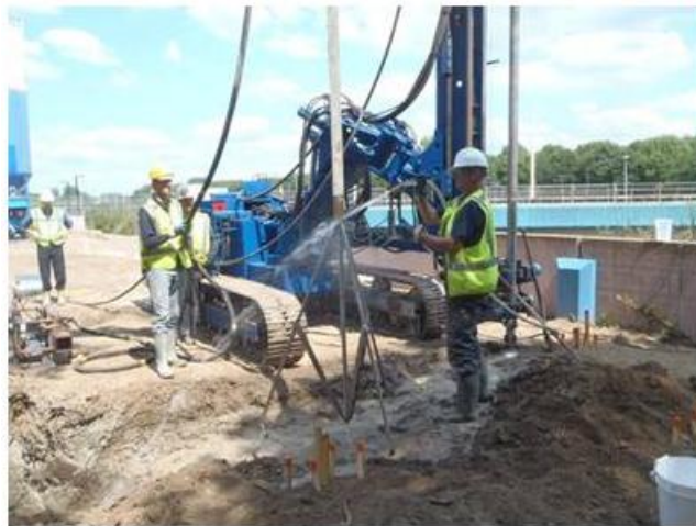
Figuur 12/7: Jetgroutproef spinmeting.
