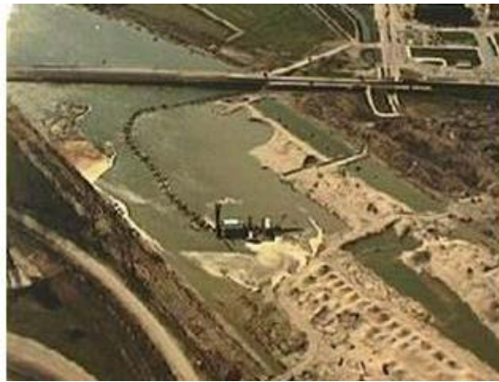
Figuur 12/3: Hydraulisch grondverzet bij aanleg verdiepte ligging A27.
