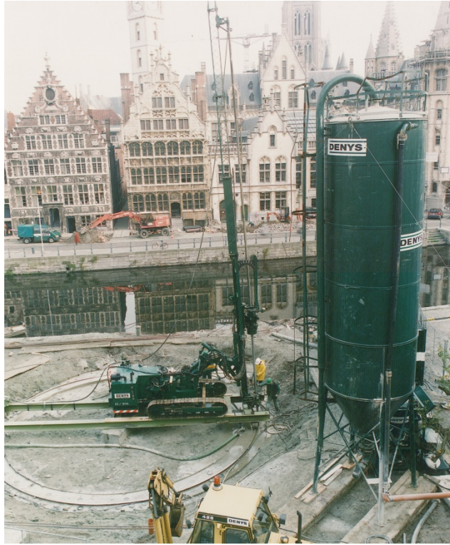
Figuur 6/9: Jet-grouting voor een cirkelvormige bouwput te Gent (Documentatie Denys).
