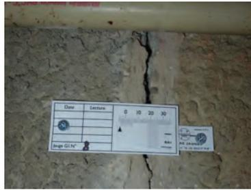
Le plus souvent, les fissures sont milli- à centimétriques mais peuvent parfois être pluricentimétriques. Les fissuromètres en permettent le suivi.
